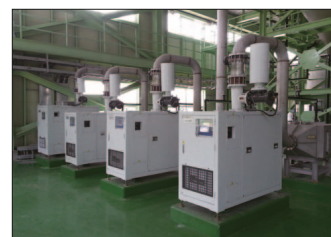
Sudokwon Landfill Site (NX150), Korea
