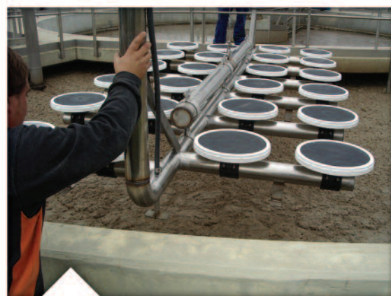
Dyfuzory dyskowe zapewniają wyjątkową zdolność natleniania w reaktorze biologicznym w Hiszpanii.
