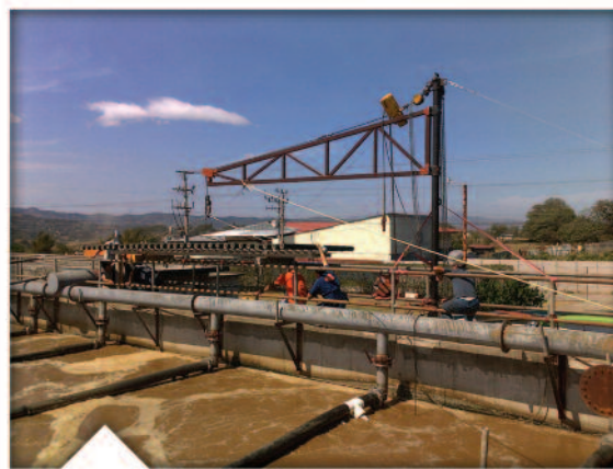
Instalacja wymowalna z dyfuzorami SSI wyposażonymi w moduł Snappy Saddle™ z ramą ze stali 304SS, która zastąpiła mało wydajny boczny system płwakowy.
